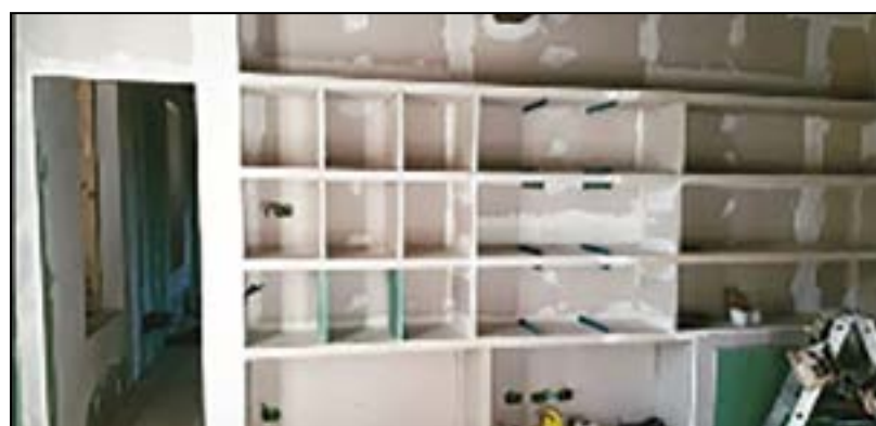
Controparete e parete arredata con inserimento porta rasomuro
