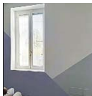
Pittura di interni
